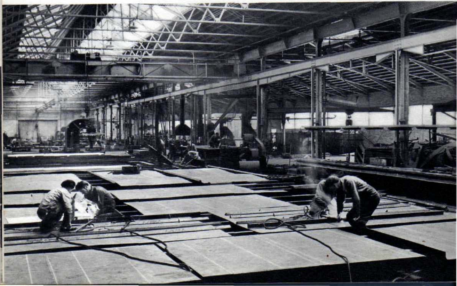
Vue d'ensemble de l'Atelier de Tôlerie.
