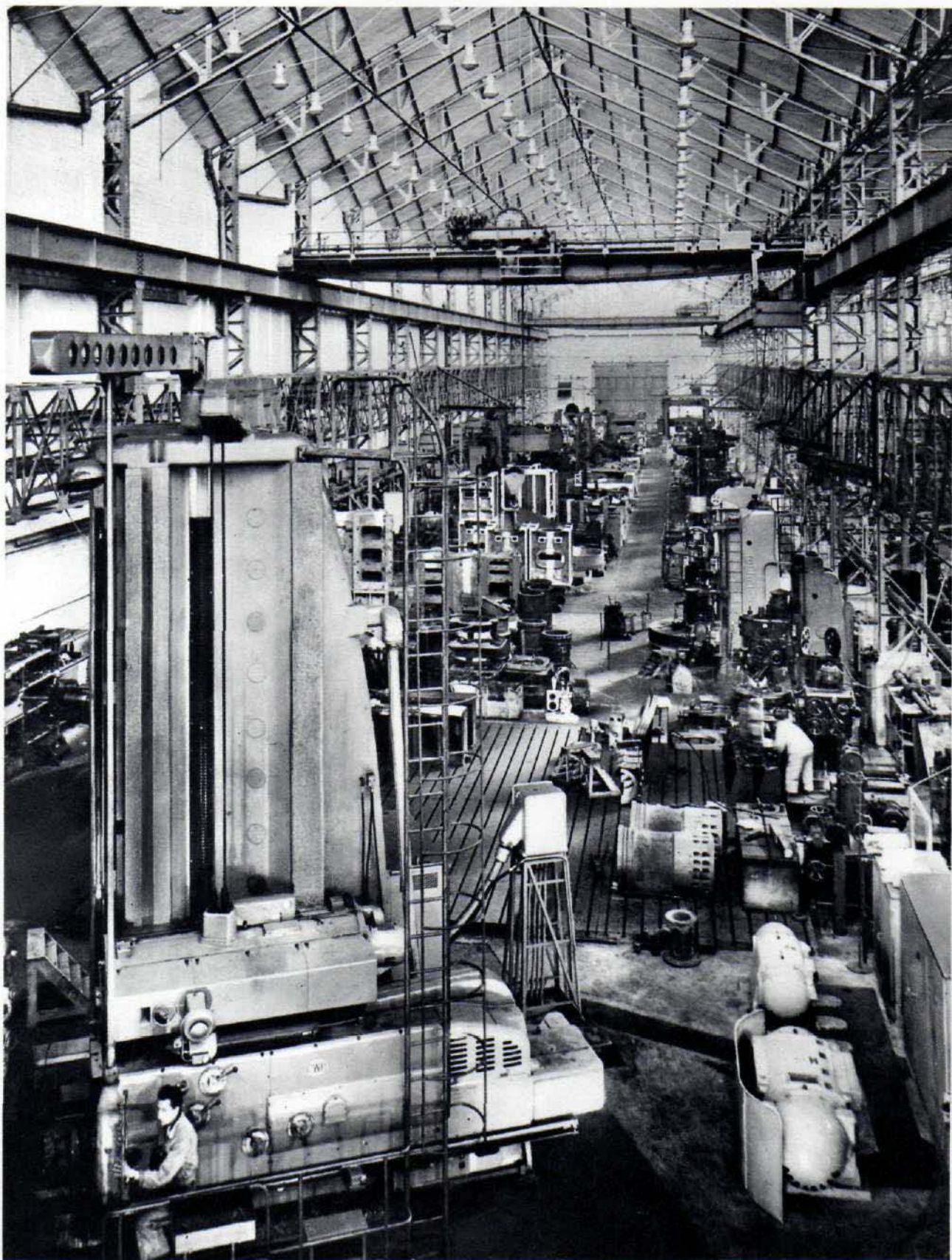
Une des quatre nefs de l'Atelier de Mécanique - Au premier plan, aléuse fraiseuse C.W.B. de 203 millimètres de broche.
