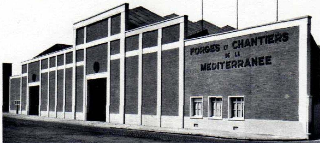
Ateliers Mazeline façade sud (1956).
