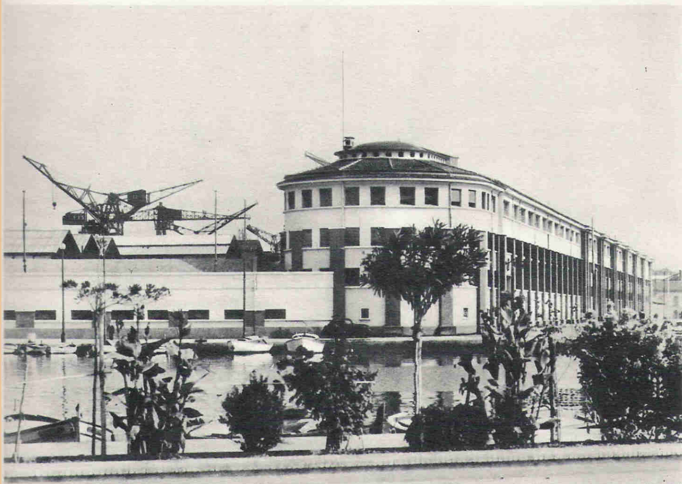
Nouveau bâtiment de la Direction (1952) de 90 mètres sur 18 mètres, il groupe les bureaux des Ingénieurs, le bureau d'études et les services administratifs.
