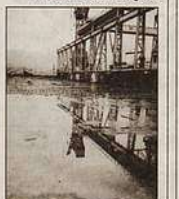
Ancien traceur aux chantiers, Michel Breil est aussi un photographe de talent
